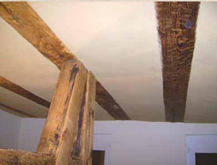
Wandbereiche und Holzbalken-Kassettendecken saniert mit Lehmbaustoffen
